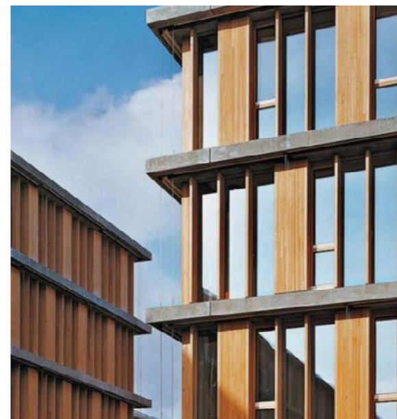
Verwaltungszentrum, Bern - GWJ Architektur
